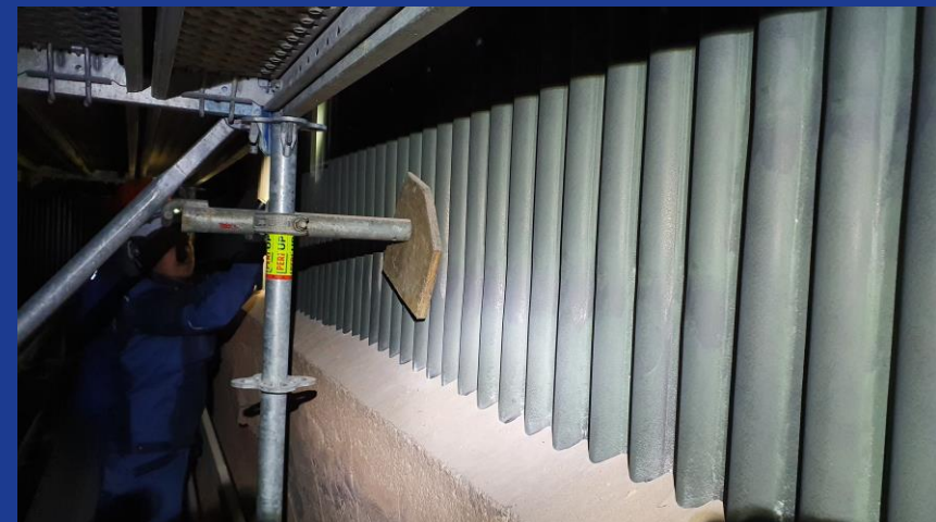
Stav stěny během revize 10.5. 2022
