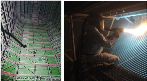
Expoziční experiment – porovnání různých dodavatelů keramických nátěrů v rozích výsypky, ČEZ a.s., Elektrárny Tušimice II., bloky C a D (2021)
