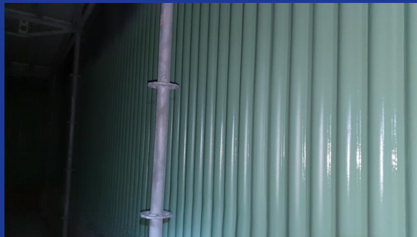
Po realizaci žárového nástřiku a keramického nátěru 30.8. 2021
